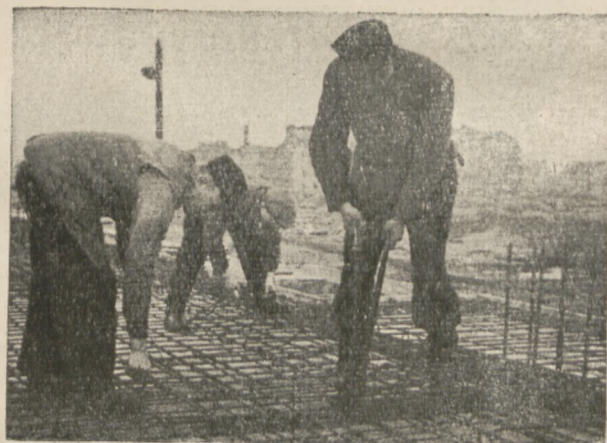
Warszawskie tempo budowy nie słabnie ani na chwilę. Wysiłek naszych dzielnych robotników tworzy Warszawę piękniejszą niż była dotąd. Oto robotnicy pracujący właśnie przy uzbrajaniu stropów nowego budynku Wydawnictwa MON „Prasa Wojskowa”, gdzie m. in. będzie się mieścić również i Wasz „Wiarus”.
