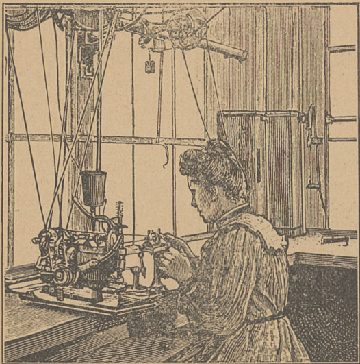
Fig. 3. Osadzanie drogich kamieni za pomocą maszynowych urządzeń.
